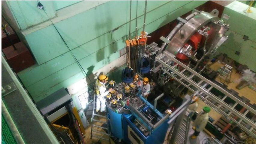
図 3.4 冷却システムの設置
